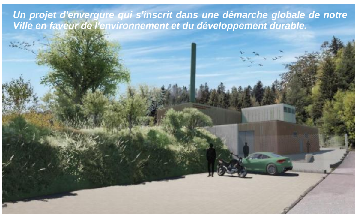
Vers la transition énergétique avec la création d'une chaufferie biomasse bois et un nouveau réseau de chauffage urbain
